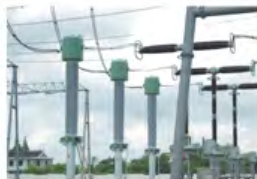
LVOB-550 气体绝缘式电流互感器在江苏省电力公司运行 LVOB-550 SF6 Insulated CT in Jiangsu Province
