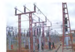
LW36-72.5 SF6 断路器在马达加斯加运行 LW36-72.5 SF6 Circuit Breaker in Madagascar
